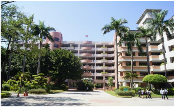
新建慧樓及智樓教學大樓
